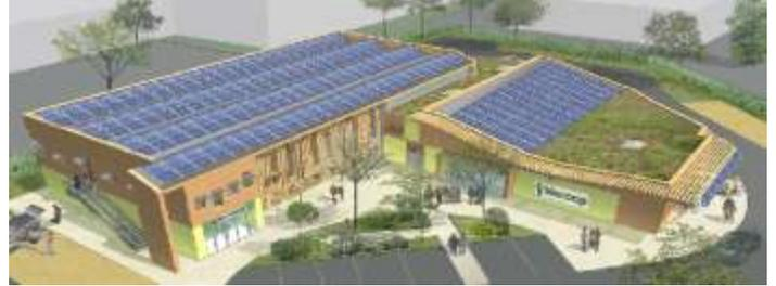
L'architecture de ce bâtiment a été conçue pour s'adapter à une gestion optimale des ressources énergétiques, dans le cadre d'un développement durable et du respect de l'environnement (panneaux photovoltaïques, toit végétalisé, récupération et régularisation de la chaleur en fonction de la température extérieure, éclairage gradué en fonction de l'éclairage naturel, etc...).
