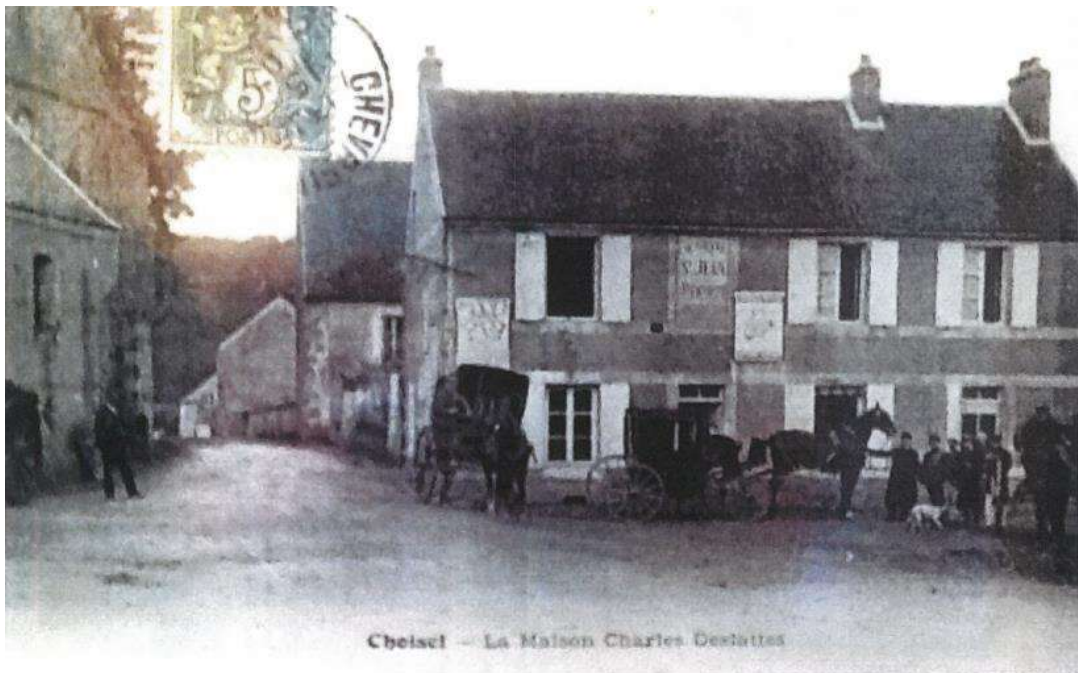
Ancienne Auberge 2 rue de la Maison forte (ancienne carte postale)
